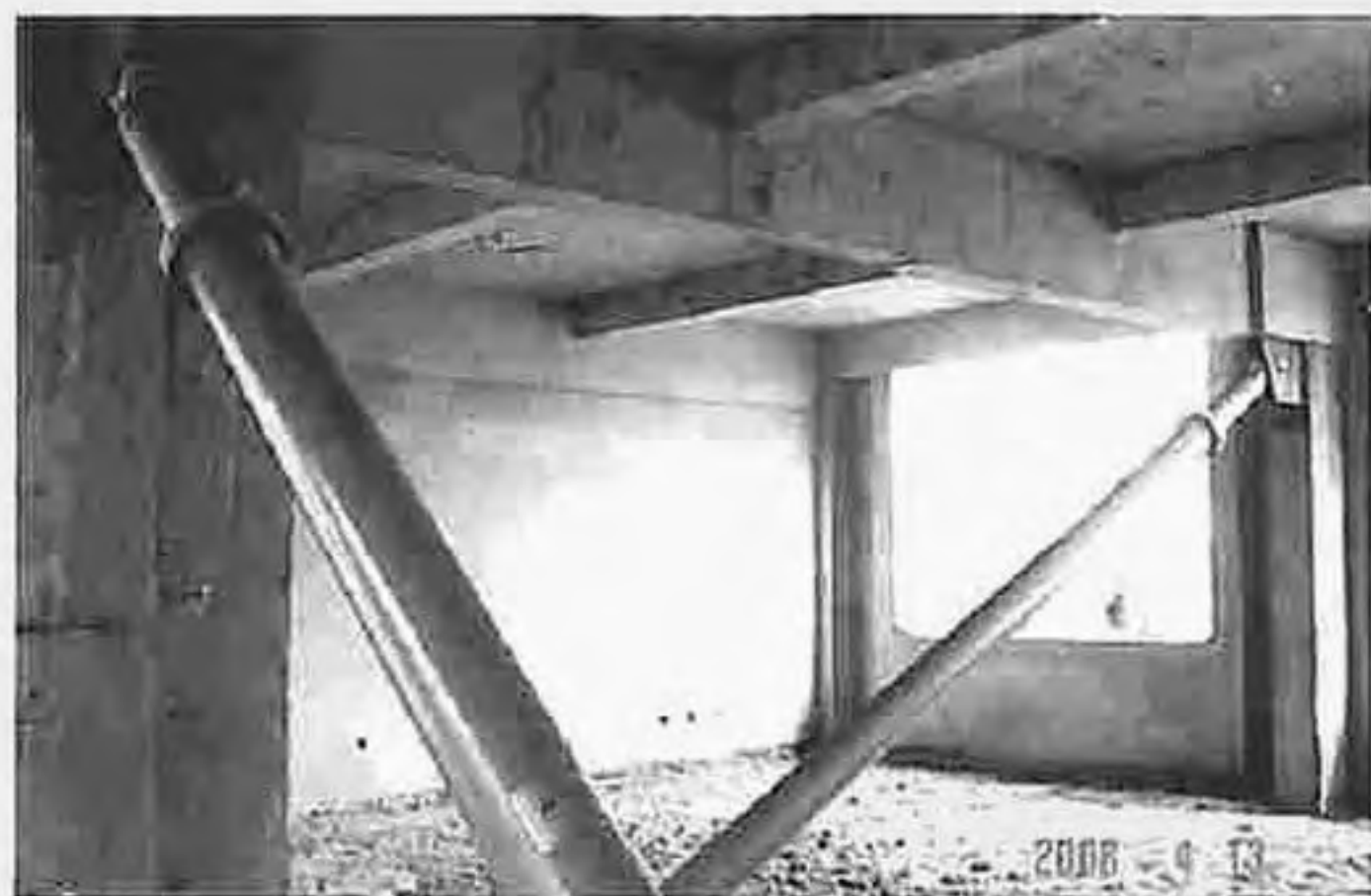
图5 宿迁市属于高烈度区，近年来建造了一批建筑，选用和安装了黏滞消能器来满足结构抗震设防的设计要求
