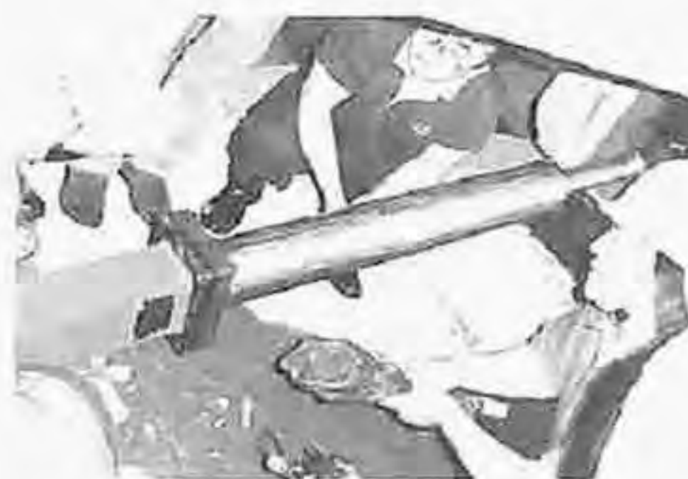
图4 北京地铁通惠家园住宅小区 (应用于隔震中的消能支撑, 粘滞消能器)
