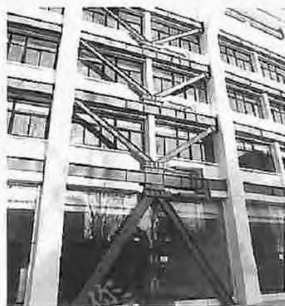
图2 北京工人体育场加固改造后的局部图 (人字型支撑, 粘滞消能器)
