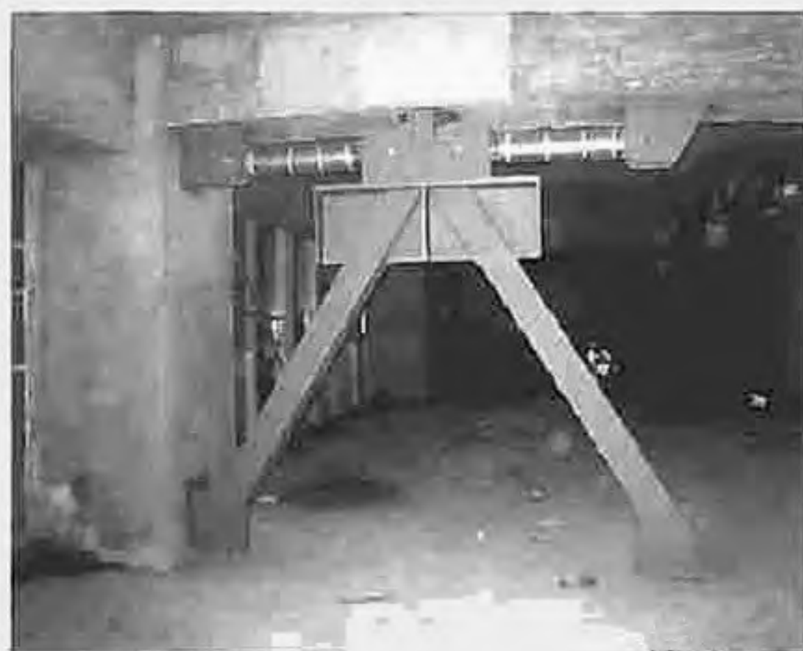
图5 宿迁市属于高烈度区，近年来建造了一批建筑，选用和安装了黏滞消能器来满足结构抗震设防的设计要求
