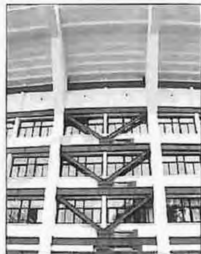
图2 北京工人体育场加固改造后的局部图 (人字型支撑, 粘滞消能器)
