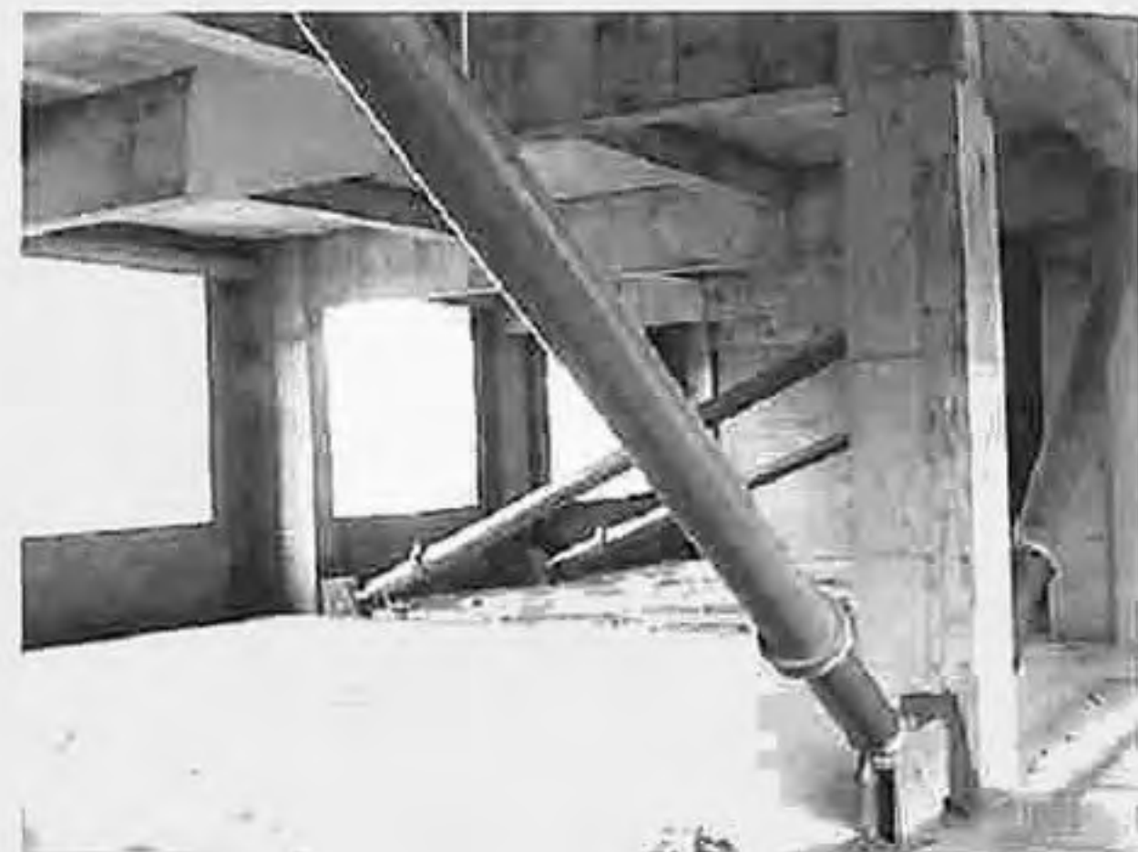
图5 宿迁市属于高烈度区，近年来建造了一批建筑，选用和安装了黏滞消能器来满足结构抗震设防的设计要求
