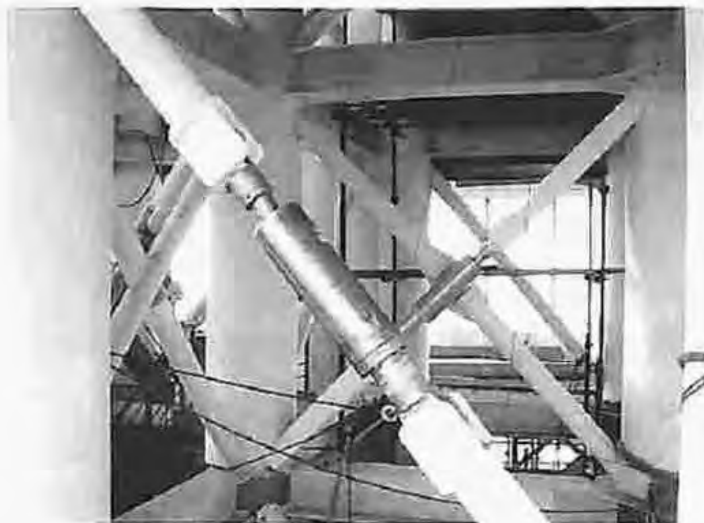
图1 南京奥林匹克中心观光塔 (单斜杆型支撑, 粘滞消能器)
