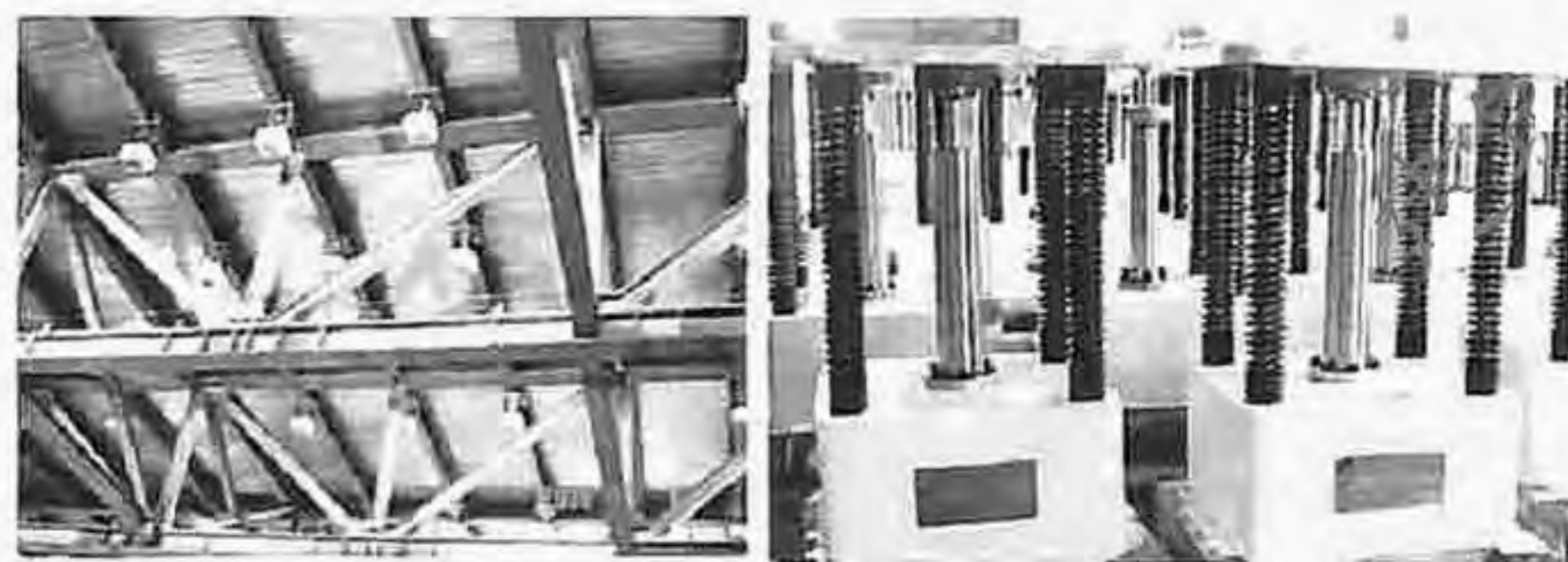
图1 南京奥林匹克中心观光塔 (单斜杆型支撑, 粘滞消能器)
